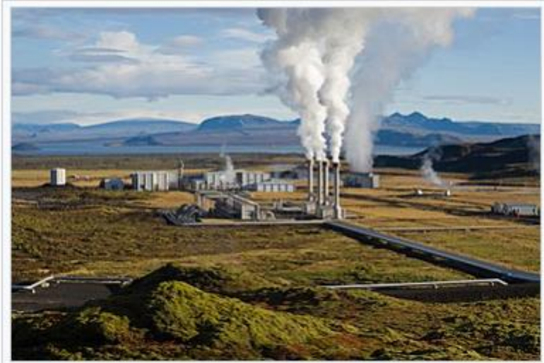
A Nesjavellir geotermikus erőmű Izlandon
